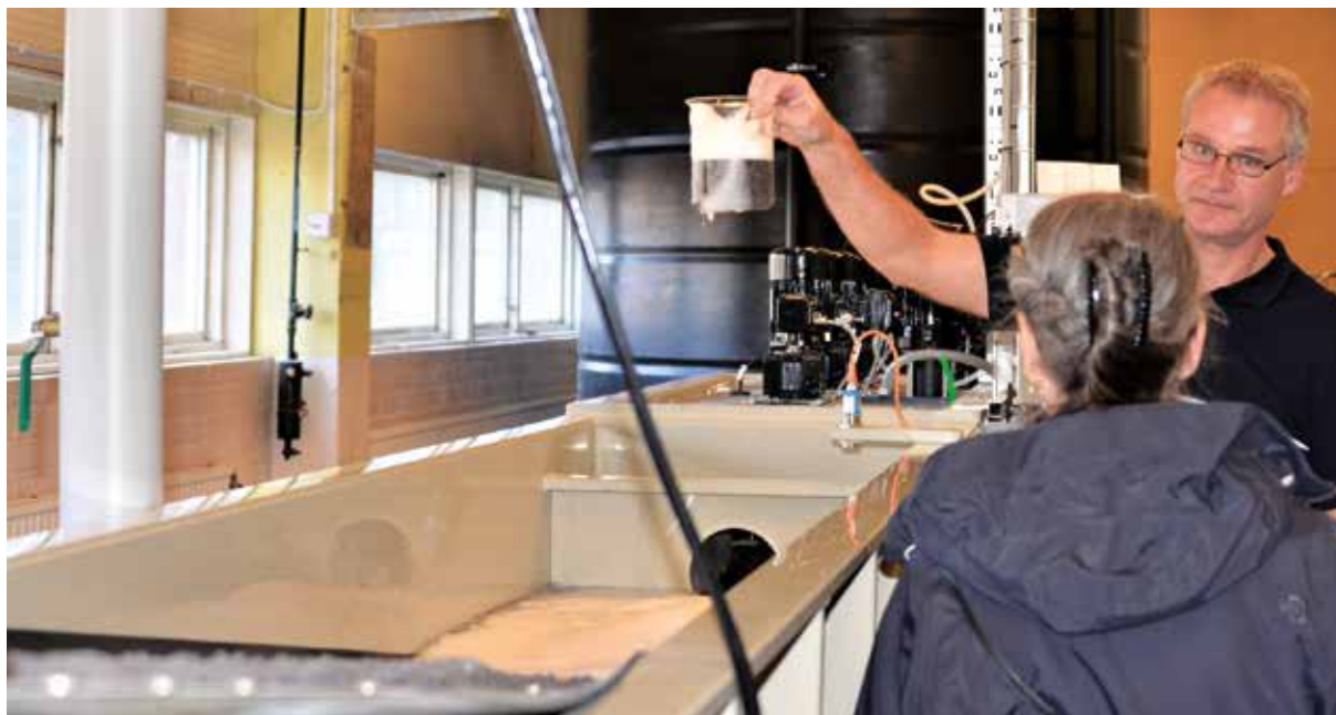
Samhalls Hans Eklöv visar upp hur effektivt den nya reningsanläggningen arbetar.
