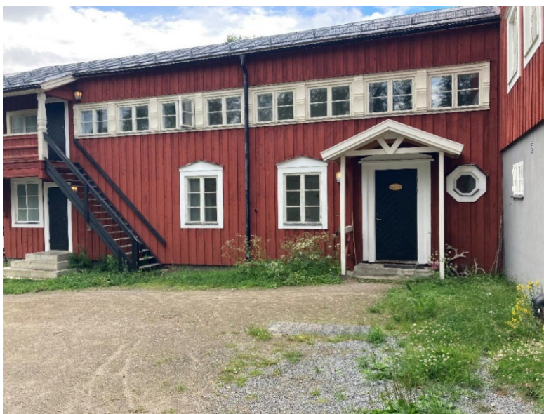
Figur 12. STF:s anläggning från 1927 (Foto: WSP 2022)
