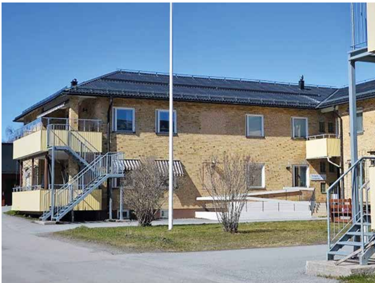
Kaitumgården byggdes i början av 60-talet och ska i relativ närtid renoveras och byggas till.
