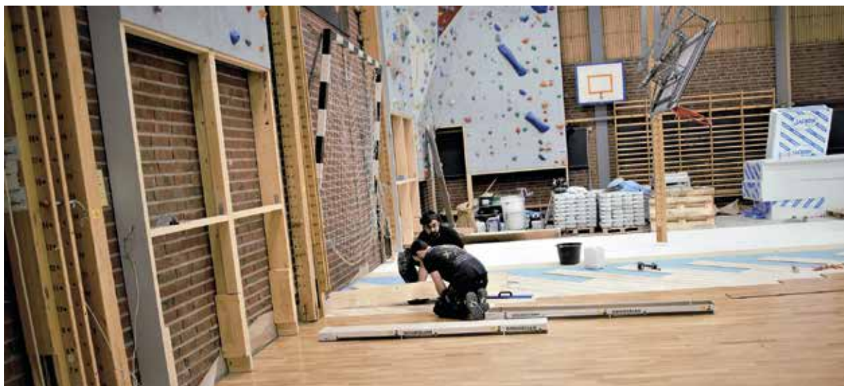
Ombyggnationen i sport- och simhallen vid Östra skolan var omfattande.
