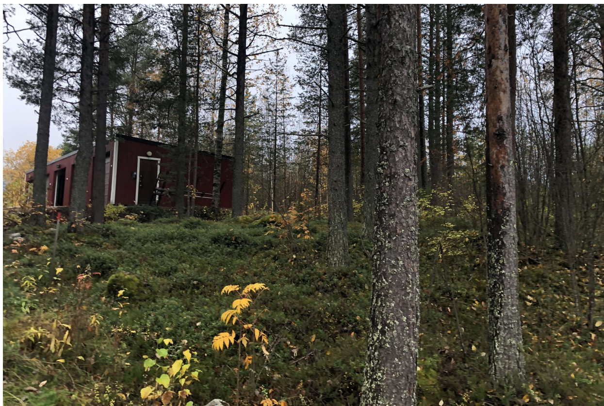
Befintlig förrådsbyggnad inom planområdets södra del.
