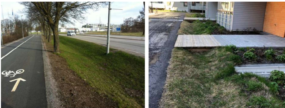
Figur 12. Foton av svackdiken, till vänster mellan GC-väg och gata och till höger inom bostadskvarter (WRS och WSP Umeå).
