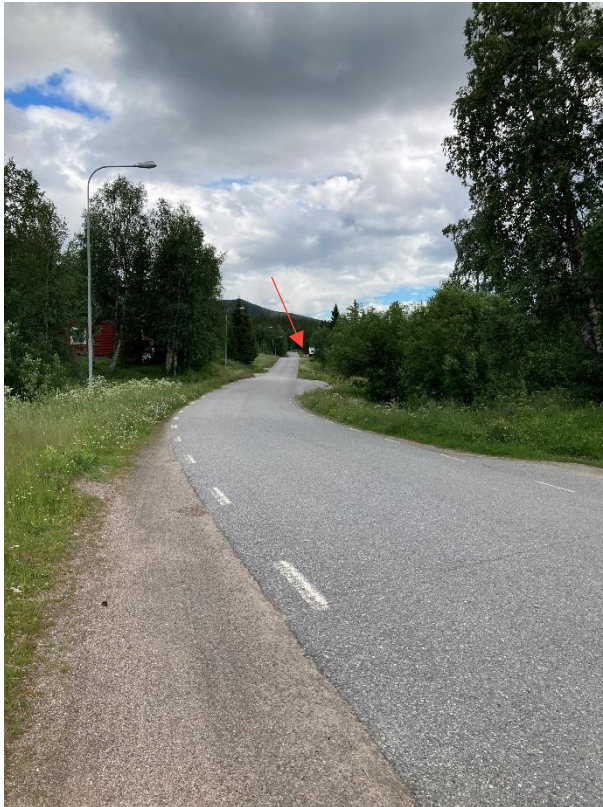
Figur 15. Vy längs Storvägen sett från vägen vid kyrkan i riktning mot söder. Röd pil visar ungefärligt läge för planområdet.
