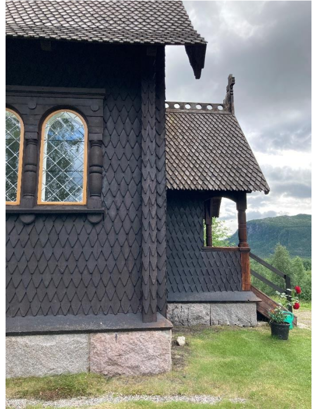
Figur 19. Fasaden och taket har klätts med sågat träspån. Ytterväggarna är målade i en blandning av rödfärg och tjära.
