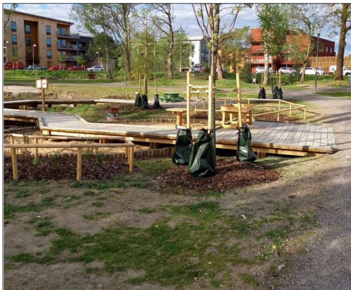
Figur 15. Torrdamm i Norrköping för fördröjning och rening som nyttjas som lekpark och vistelseyta i torrperioder. Bildkälla: WSP Umeå
