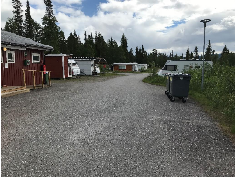
Figur 19. Campingens infart, servicebyggnad till vänster i bild.
