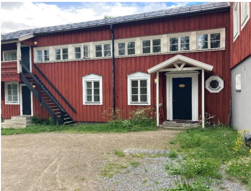
Figur 13. STF:s anläggning från 1927 (Foto: WSP 2022)
